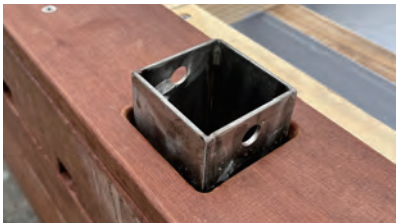
柱や手すりを設置するための差し込み穴
